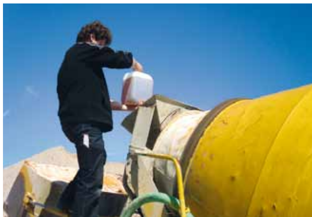
Aufbau einer Deckschicht mit biologischem Bindemittel: das Konzentrat wird mit dem Oberflächenmaterial gemischt.
