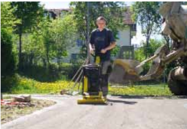
Das eingebaute Material wird verdichtet. Die Enzyme des biologischen Bindemittels bewirken eine Kristallbildung.
