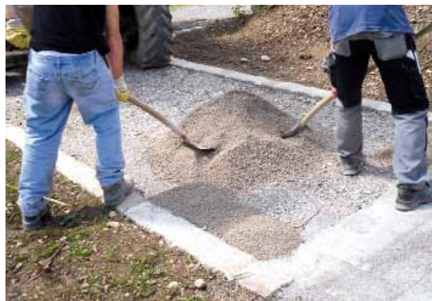
Einbau des Gemischs aus Bindemittel und Kies bei einer wassergebundenen Wegedecke (Chaussierung).
