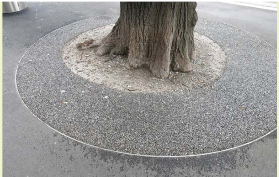
Die Baumscheiben an der Bahnhofstrasse in Zürich wurden im Rahmen der Sanierung mit dem kunstharzgebundenen Belag StoneFix ausgeführt.
