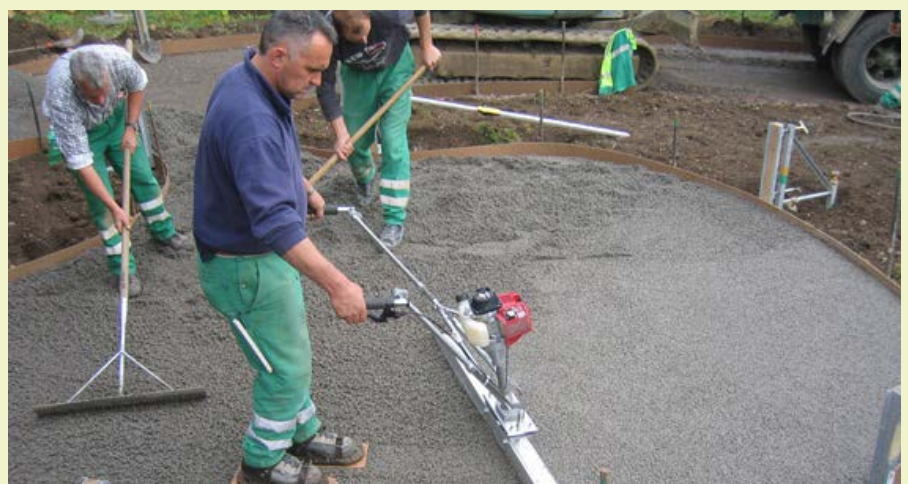
Saibro Festkies wird von zertifizierten Einbauunternehmen eingebaut.
