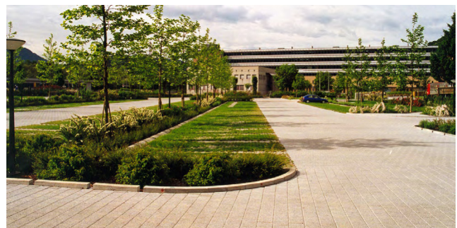
Abb. 39: Beispiel für Rasenfugenpflaster als Parkplatz, Lugano Suglio
