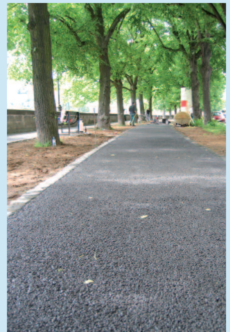
Teststrecke in Würzburg nach Fertigstellung. Für die Produktion von Saibro wurden Kiese aus der dortigen Region verwendet.
